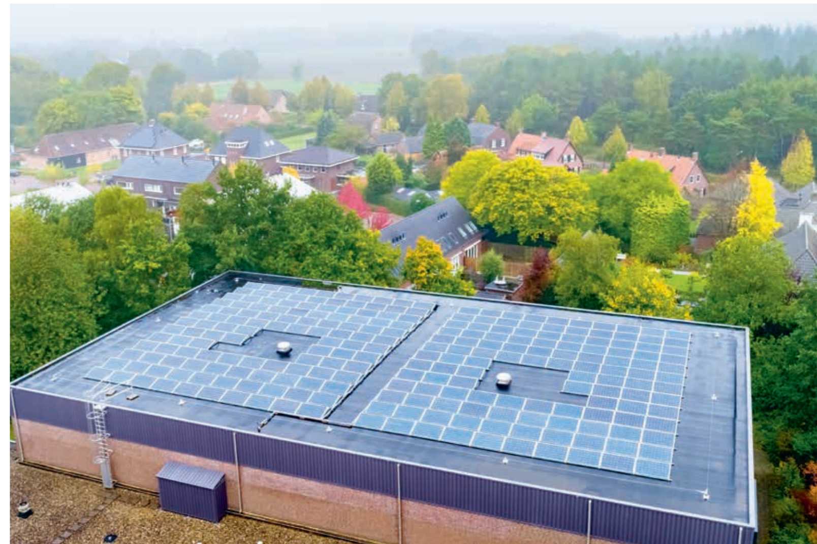
Veilige PV-installaties hebben een kleinere kans op het ontstaan van een brand. (Foto: aangeleverd via ProBitumen)
